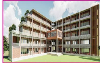
নবনির্মিত স্কুল ভবন
